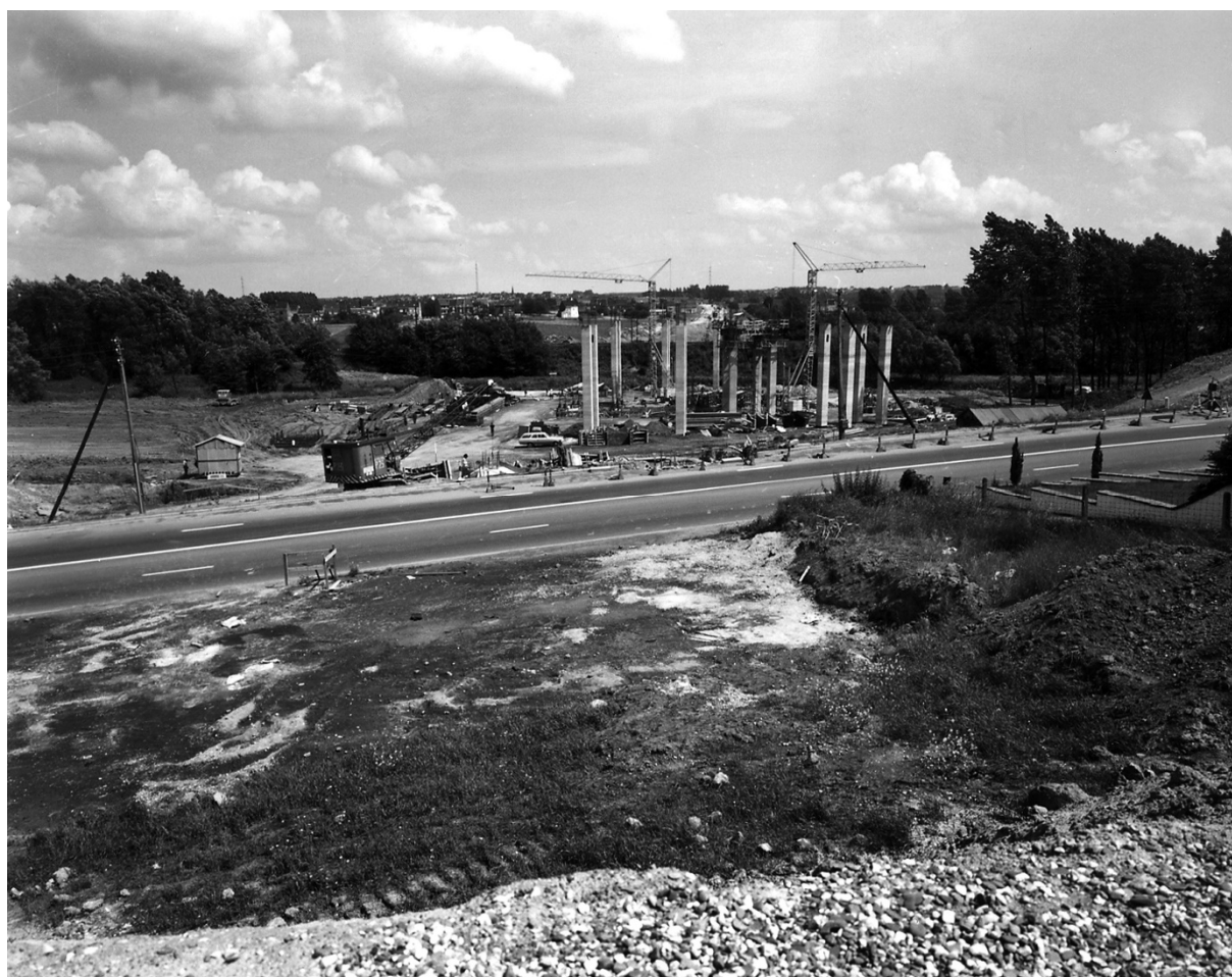
Bouw van het viaduct van de E429 omtrent 1967.
